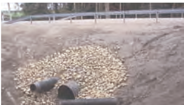
Leppojan rumpu, halkaisija 1,2 m, valmiina. Tulvapatkii 400 mm ja rummutetun sivuojan putkii 315 mm.
