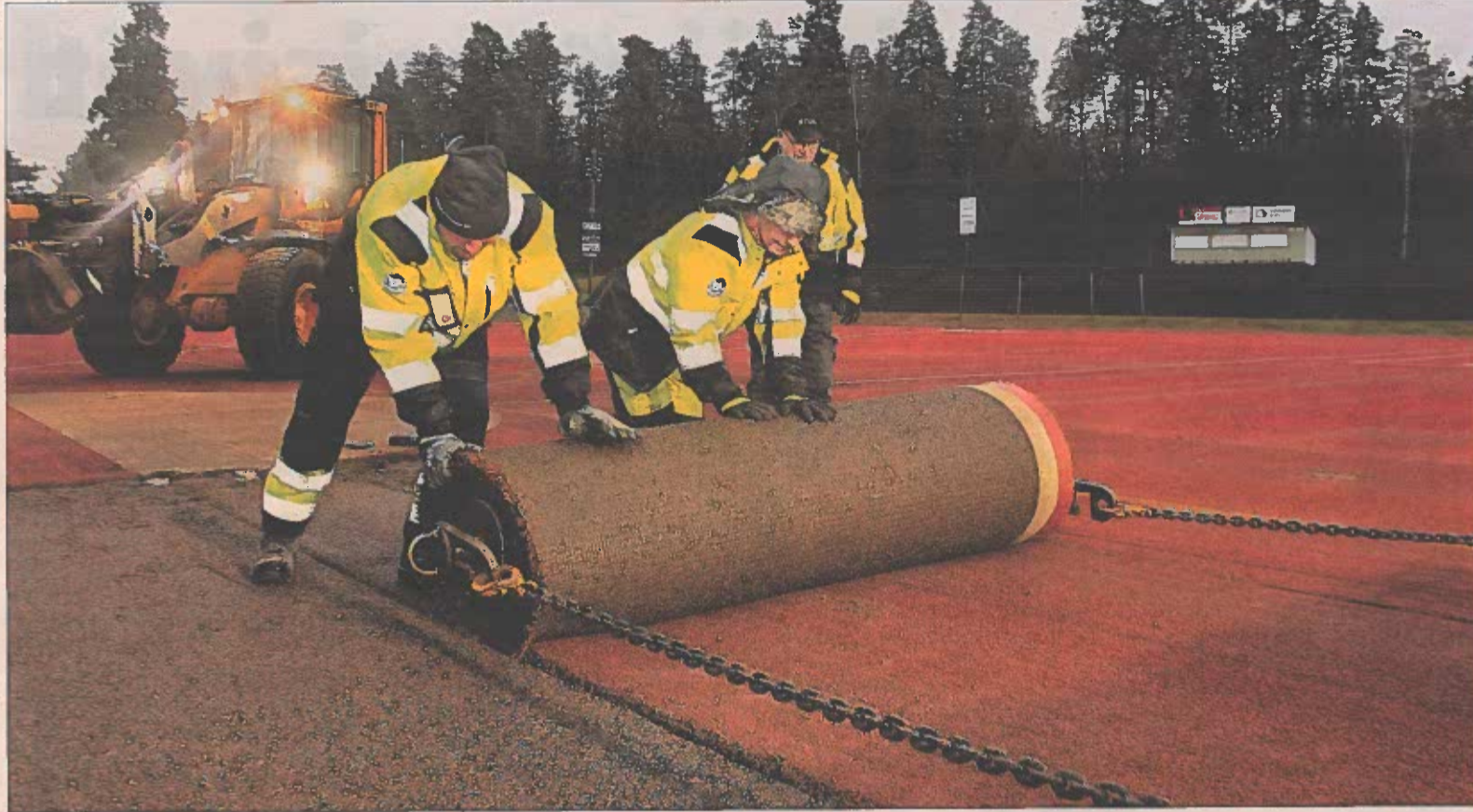
Pekka Seppälä, Kati Kiviniemi ja Pentti Ojala avustavat vanhan hiekkatekonurmen irrottamisessa. Pyöräkuormaajan ohjaimissa on Jouni Joensuu, joka vetää noin puolitoista metriä leveän nurmikaistaleen rullalle. Uusi hiekkatekonurmi on aikanaan lähes 7000 neliötä.
